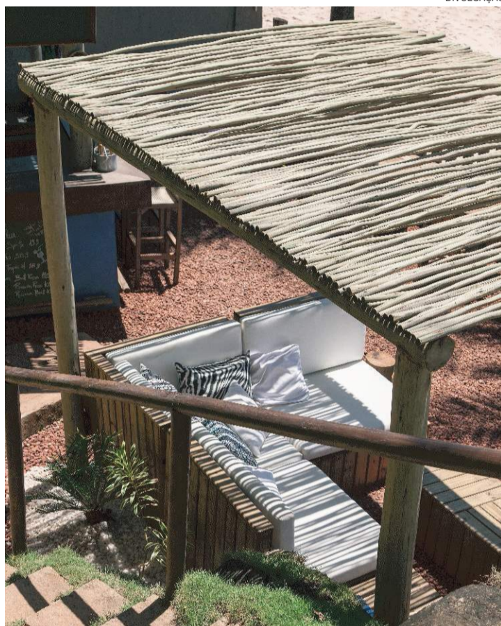
Pergolado coberto com gravetos de eucalipto é alternativa a tecido
