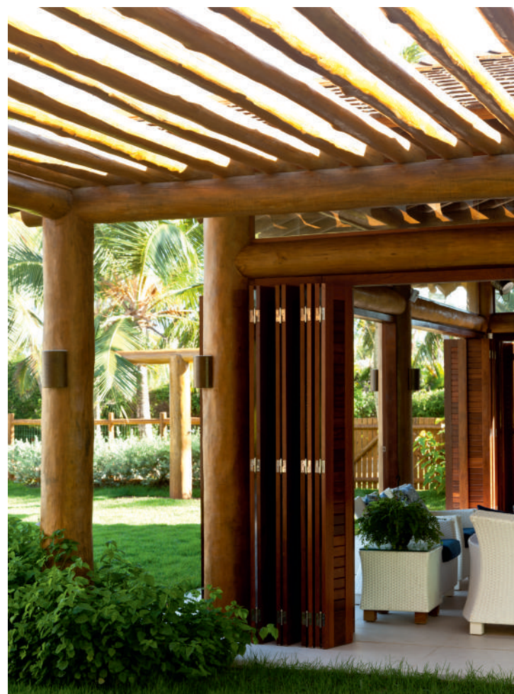
A estrutura mista de eucalipto e concreto armado confere autenticidade à obra, além de atender à solicitação dos moradores por uma casa contemporânea, sem, no entanto, perder a atmosfera rústica desejada The mixed structure of eucalyptus and reinforced concrete imparts authenticity to the construction and also satisfies the owners' request for a contemporary house, without losing the desired rustic atmosphere though.
