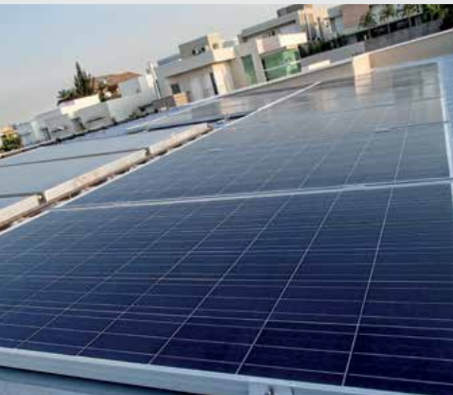
Placas solares garantem 70% da energia
