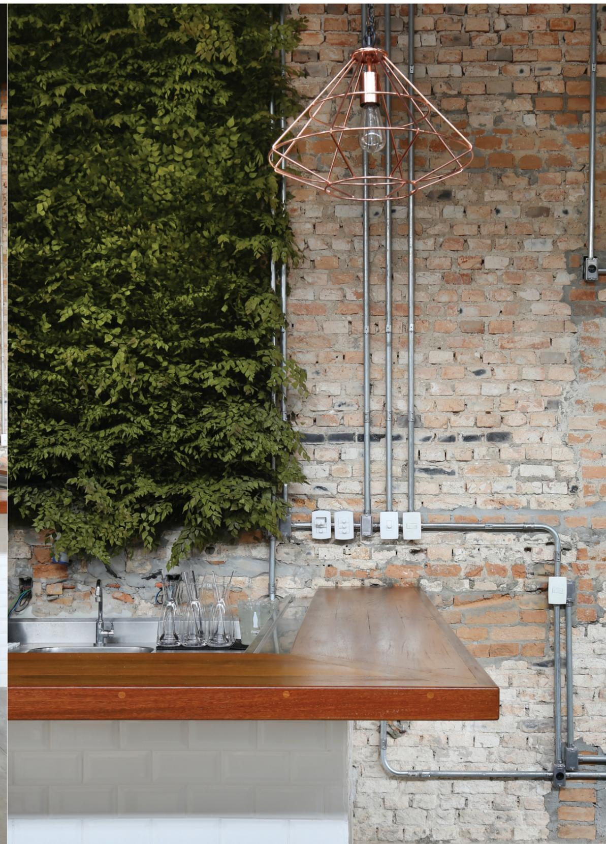
TUBULAÇÃO APARENTE: OS DUTOS METÁLICOS POUPARAM INTERVENÇÃO NA PAREDE ORIGINAL, DE TIJOLOS DE BARRO
